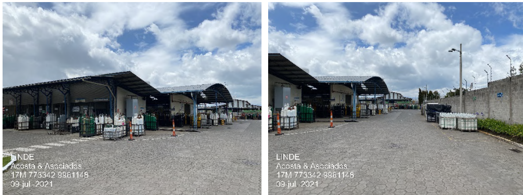
Ilustración 17. Vista General de la Planta
