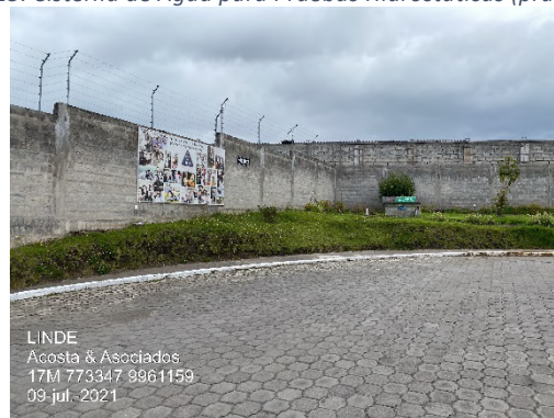
Ilustración 25. Cisterna de Agua para Pruebas Hidrostáticas (pruebas PH)(9 m3)
